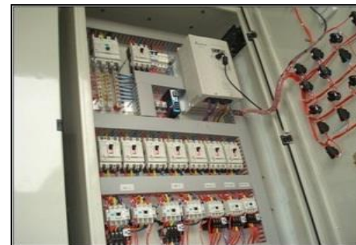
Cụm tủ điều khiển hệ thống chiller
