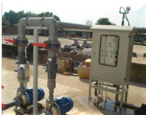
Công ty Massan – Tập đoàn Massan Ứng dụng VFD-CP2000 cho Tủ bơm điều áp
