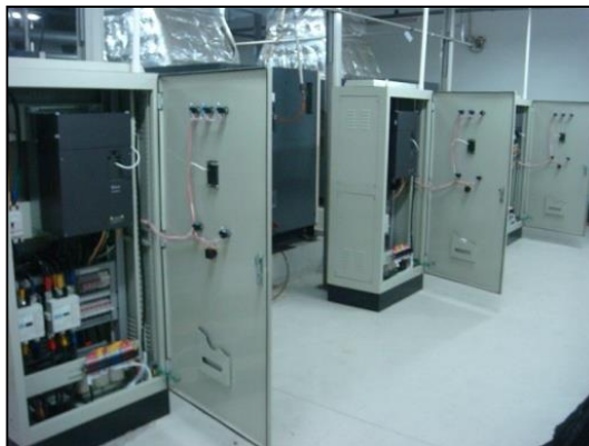
Công ty Panasonic Việt Nam Ứng dụng C2000 cho hệ thống máy nén khí
