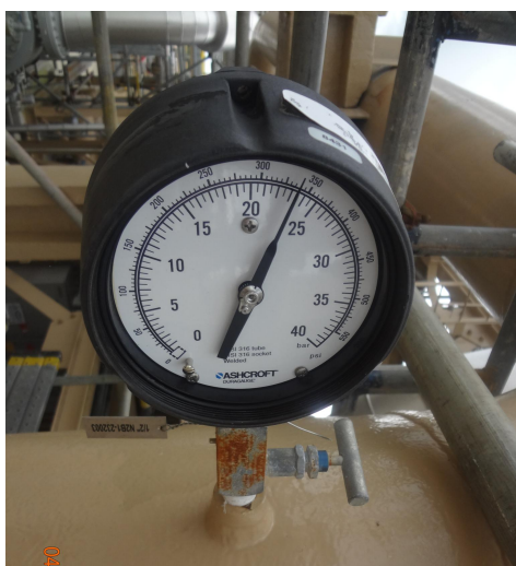
Đo áp suất đường ống Gas
