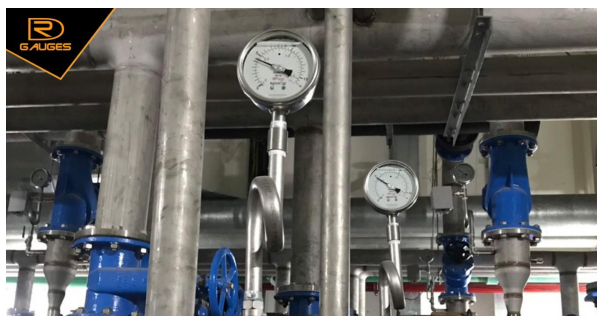
Đo áp suất đường ống nước cấp Resort
