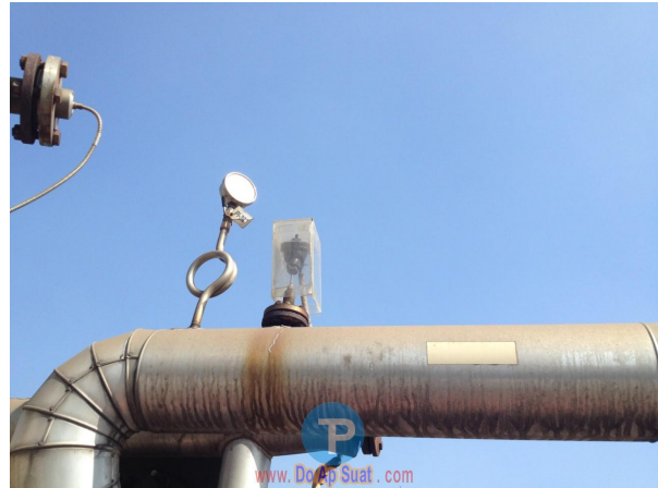
Đo áp suất đường ống hơi nóng
