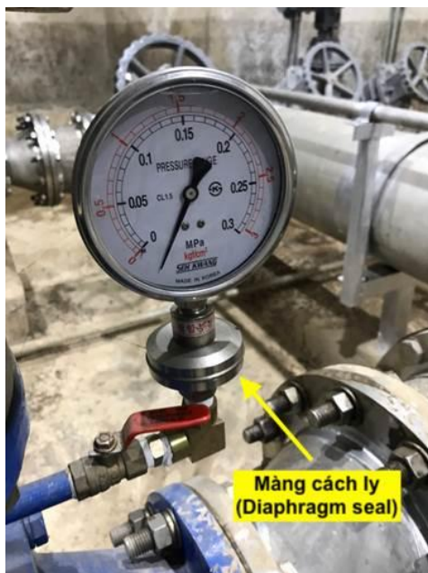
Hình ảnh đồng hồ áp suất dạng màng lắp đặt thực tế
