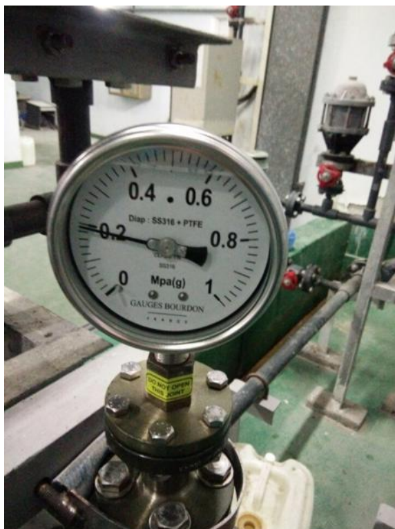
Đo áp suất đường ống nhà máy xử lý nước thải
