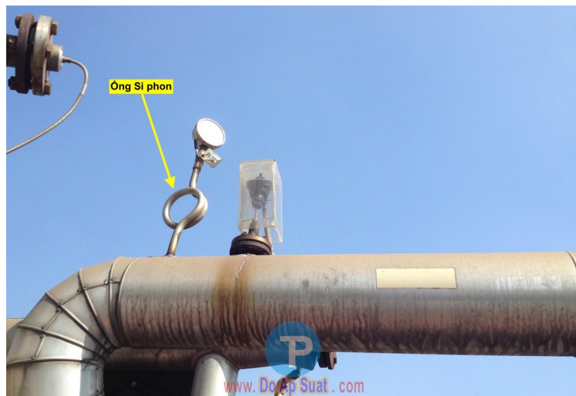
Hình ảnh đồng hồ lắp có ống siphon
