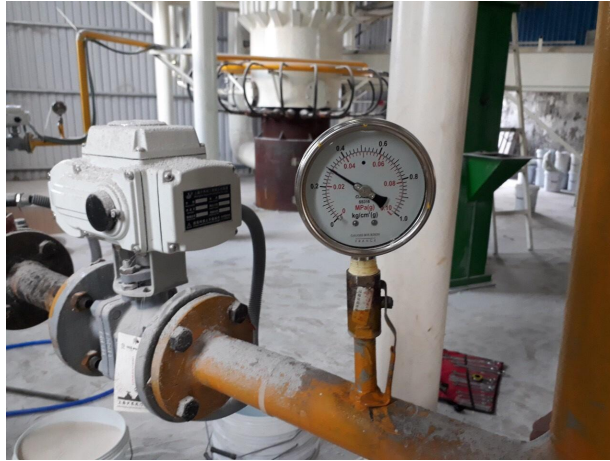
Hình ảnh đồng hồ áp suất Bourdon được lắp đặt trên đường ống Gas
