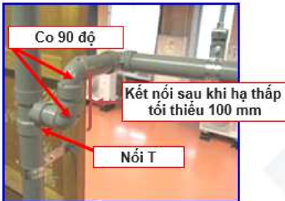
Kết nối tới ống phương đứng bằng nối chữ T
