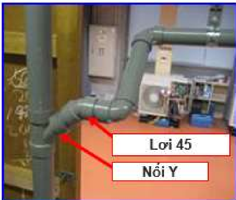
Kết nối tới ống phương đứng bằng nối chữ Y
